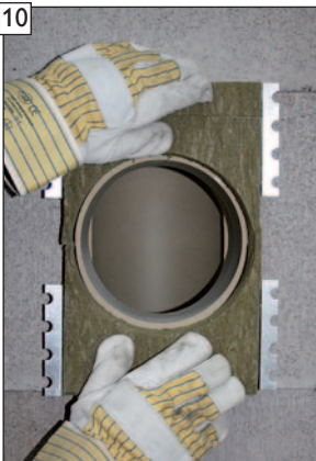
Jetzt die zugeschnittene BDF in die Mantelsteinöffnung einbringen und ...
