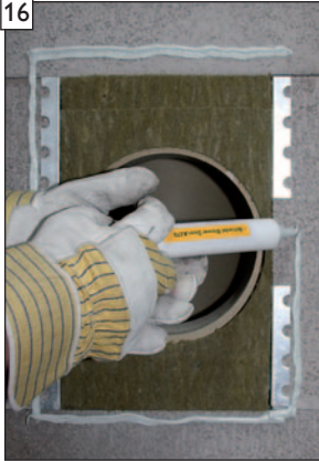
BlowerDoor A270 Dichtheitskleber ( vor Frost schützen ) auftragen - 8 mm Raupe. WICHTIG! Auf umlaufend vollständig geschlossenen Kleberauftrag achten!
