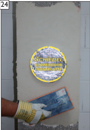
Auftrag und Veredelung Oberputz.
