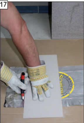
Spezial-Alugewebefolie kann bei Bedarf zugeschnitten werden. Mindestüberdeckung zur Mantelsteinöffnung beträgt 20 mm. ACHTUNG! Spezial-Alugewebefolie darf dabei nicht beschädigt werden (Unterlage verwenden)!
