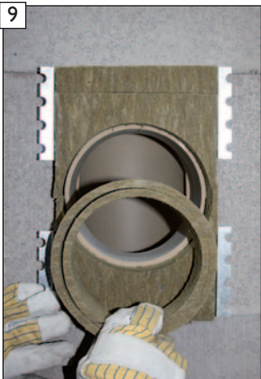
Bei D12-18 die nicht erforderlichen Innenkernringe vor dem Einsetzen herausnehmen.
