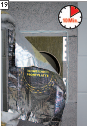
Spezial-Alugewebefolie innerhalb von 10 Minuten ausgerichtet ansetzen und ...
