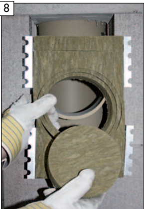
Inneren Stützkern entfernen.
