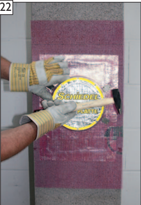
Putzring mit Putzgewebetträger annageln. ACHTUNG! Spezial-Alugewebefolie darf dabei nicht beschädigt werden!
