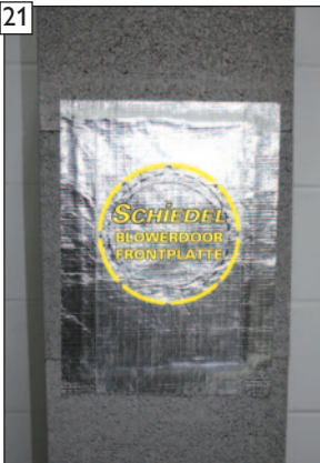
Fertigansicht ACHTUNG! In der Aushärtungsphase darf keine Bewegung durch Zug an der Spezial-Alugewebefolie ausgeübt werden!
