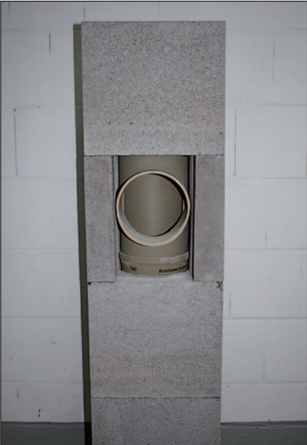
Ansicht Rauchrohranschluss vor dem Einbau
