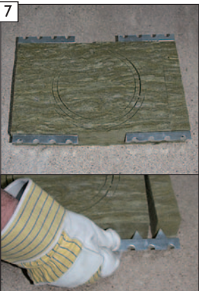
Haltewinkel in die BDF einstecken. Mit den oberen Haltewinkeln den angelegten BDF-Abschnitt fixieren.
