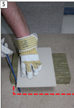
BDF mit der Dämmstoffsäge und der Schnittschablone (als Anschlagführung) zuschneiden. Den entstandenen BDF-Abschnitt an der Oberseite anlegen. Der innere Stützkern bleibt dabei als Aussteifung in der BDF.
