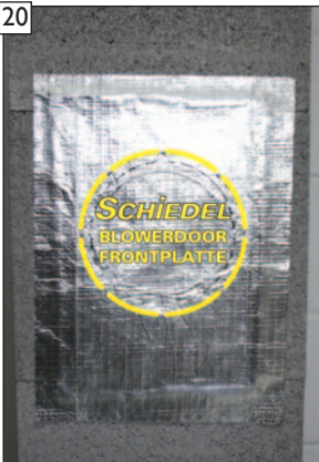
... umlaufend dicht andrücken. ACHTUNG! Nicht unter 4 mm flachdrücken! Spezial-Alugewebefolie darf dabei nicht beschädigt werden!
